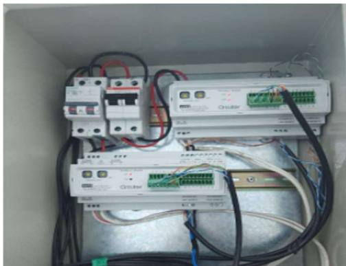
Fotografía C.11: Conexión del TRH16-RS485 Fuente: Carrera de Electromecánica
