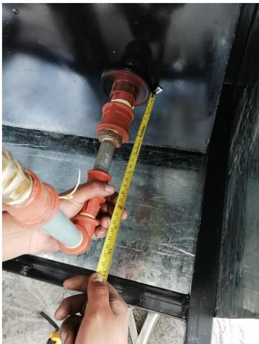
**Fotografía 13.** Instalación de tubería para líquido caliente
