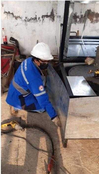
**Fotografía 11.** Colocación del perno auto perforante
