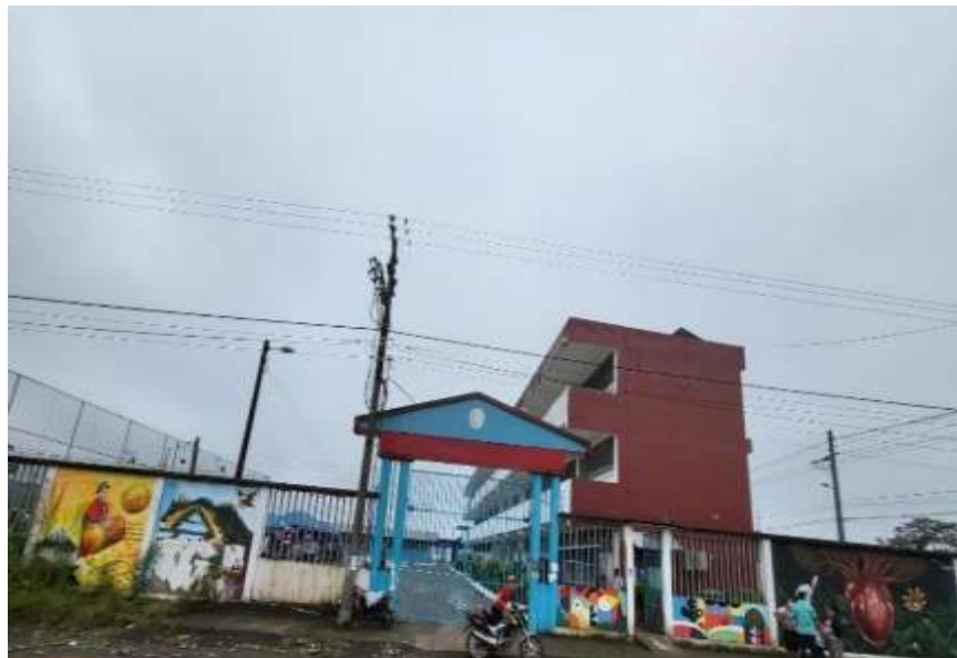
Figura 30. Fachada exterior del Bloque B Extensión La Maná
