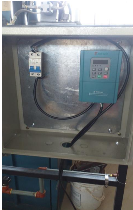
Imagen 20: Instalado el panel de control Elaborado por: Paz. C. (2022)
