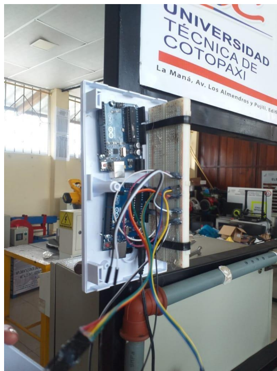
Imagen 22: Instalación del Sistema de control Elaborado por: Paz. C. (2022)
