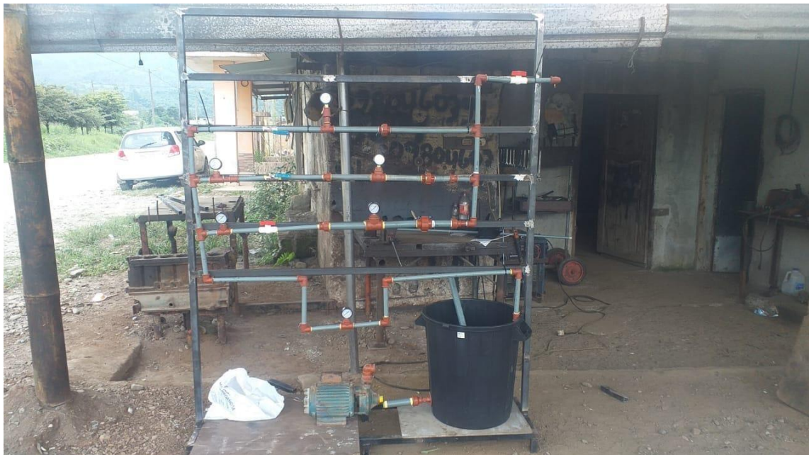
Imagen 16: Instalación de prueba Elaborado por: Paz. C. (2022)
