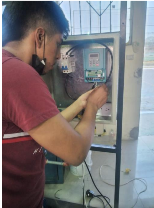
Imagen 19: Instalación del variador Elaborado por: Paz. C. (2022)
