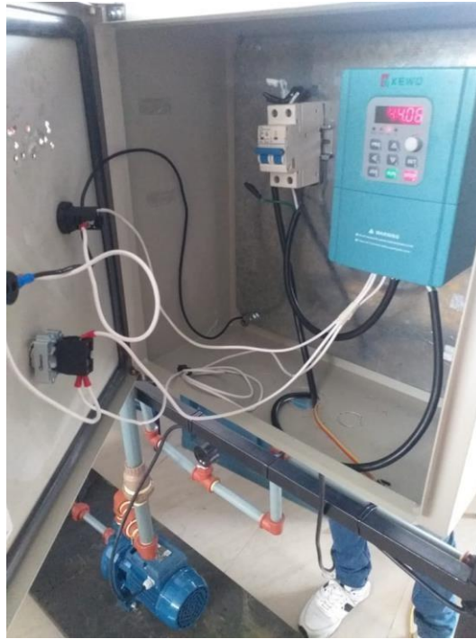
Imagen 21: Instalación de selector y luces piloto Elaborado por: Paz. C. (2022)
