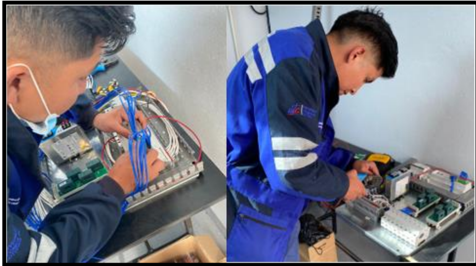
Figura 3. 14: Armado de tablero de control
