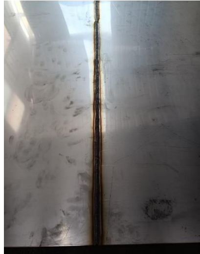
Soldadura de las planchas
