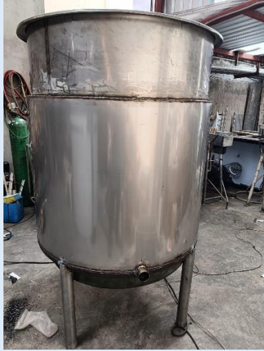
Colocación de las patas del tanque
