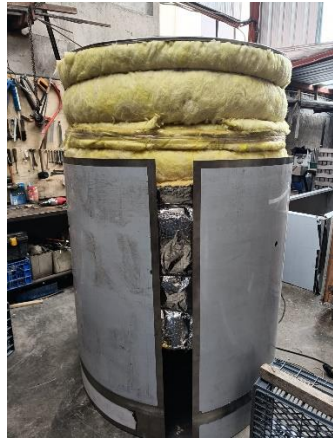
Colocación de la lana de vidrio y forro
