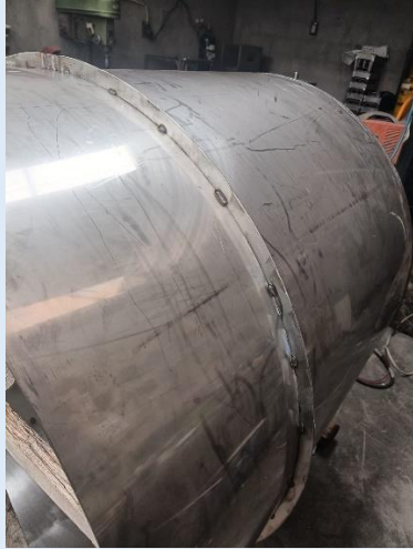
Colocación y pinchado del ángulo
