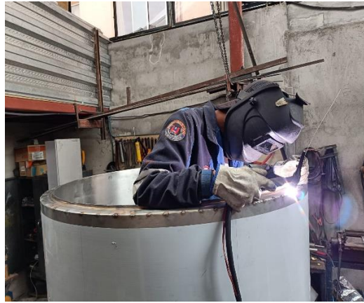
Soldadura del tanque completo y pulido
