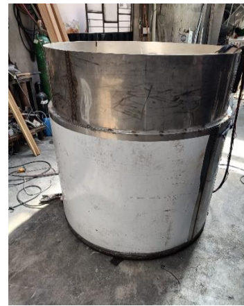
Unión de los dos tanques el principal y el segundo fondo interno
