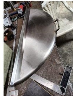
Construcción de las tapas abatibles
