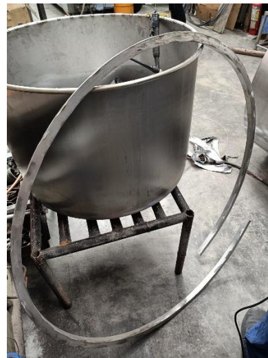
Biselado del interior del tanque
