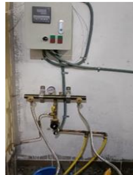
Colocación del centralizador
