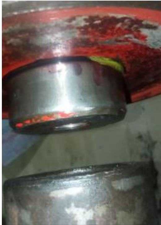
Figura 3.14: Detección de fuga
