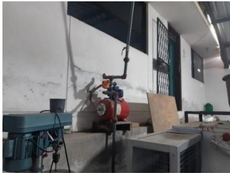
Figura 11: Bomba para succión de agua de la cisterna.
