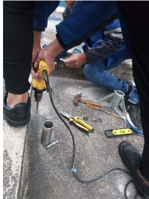
Fotografía 2: Instalación de internet para el área de energías renovables
