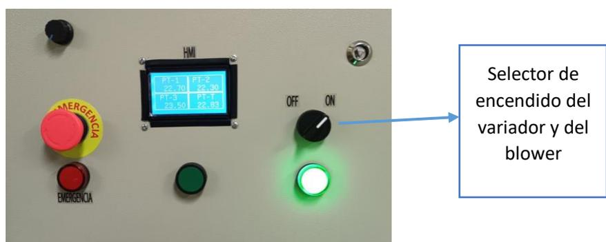
**Figura 9.4** Selector para el encendido del variador y del blower.
