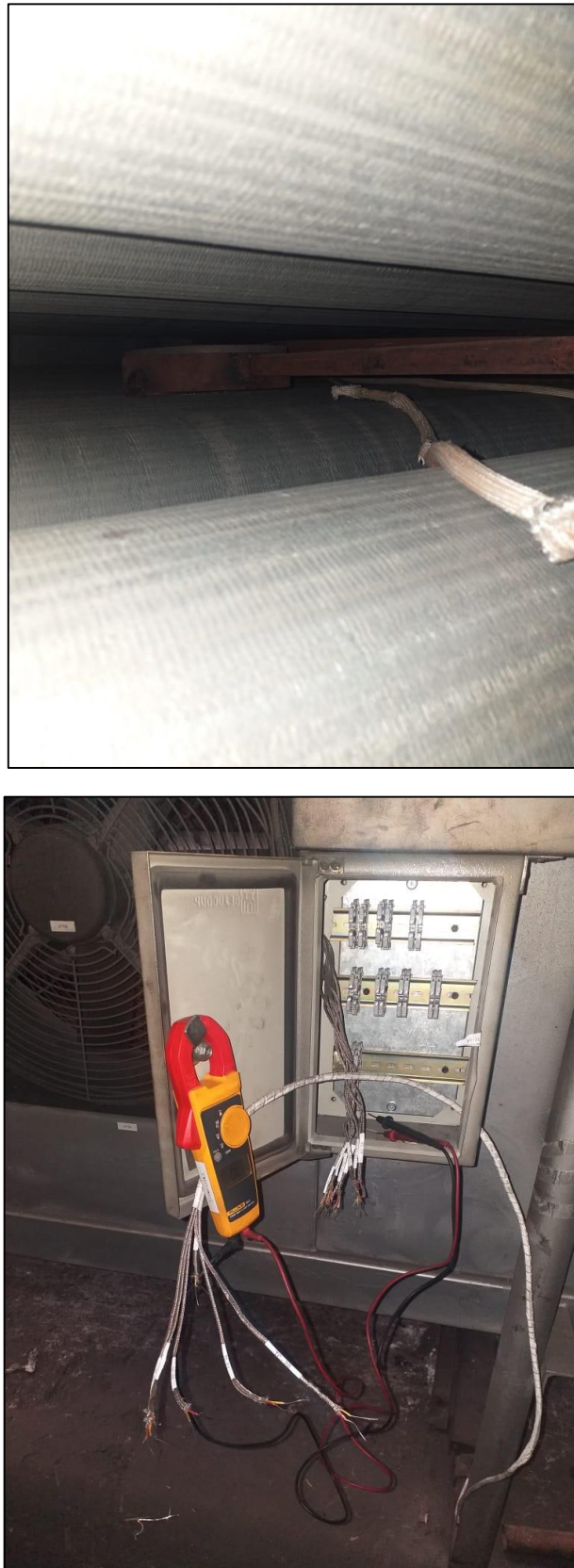
Figura II.5. Conexión del cable termopar o cable extensión
