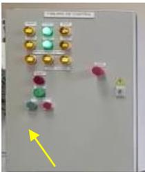
**Paso N°11.-** Variar la frecuencia en 50Hz y 40 Hz y realizar el paso N9, con el tacómetro medir las revoluciones del motor de la bomba.
