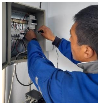
Fotografía C.8: Instalación del PV-Monitor-M. Fuente: Carrera Ing. Electromecánica.
