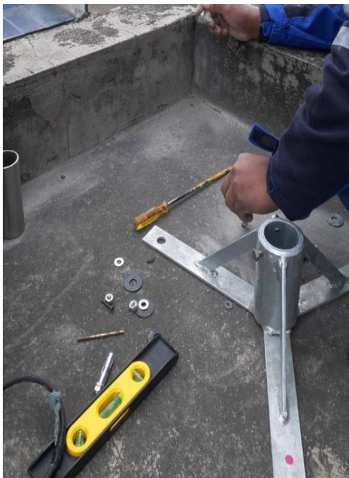
Fotografía B.3: Instalación de la base Fuente: Carrera de Electromecánica
