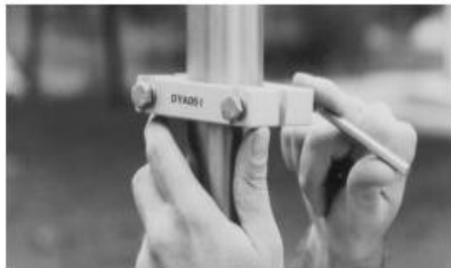
Figura 4.5: Colocación del collarín
