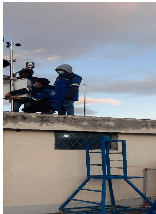
Fotografía B.4: Instalación del cajetín de conexiones Fuente: Carrera de Electromecánica
