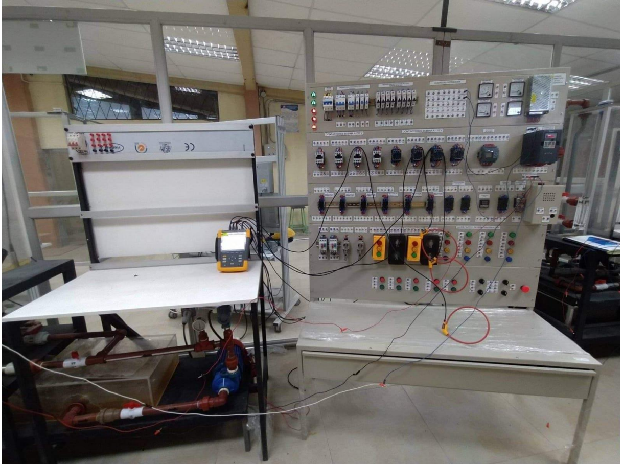
Figura 8.1 conexión del analizador de calidad de energía en los diferentes arranques. (autores)
