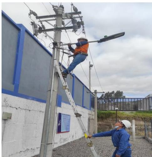
**Figura 4. 4.** Instalación del luminario LED.
