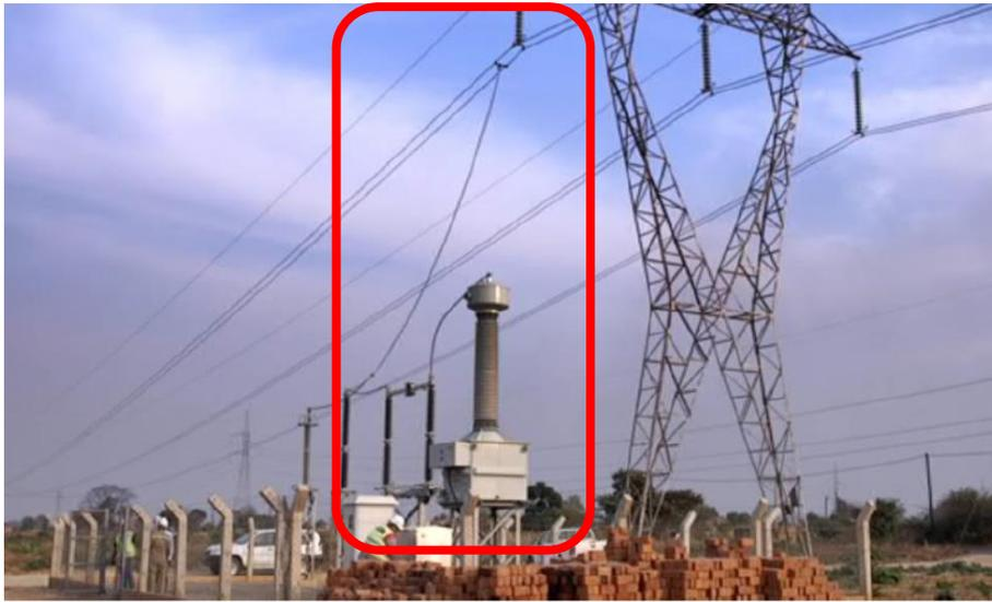
Figura 14 SSVT conectado a la línea de alta tensión [8]
