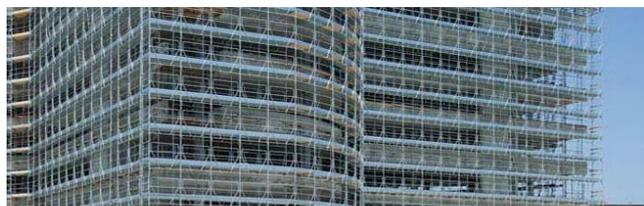
Un andamio multidireccional permite una gran variedad de configuraciones y una alta confiabilidad por su excelente resistencia mecánica.
