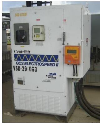
Fig. 11. Variador de frecuencia.
