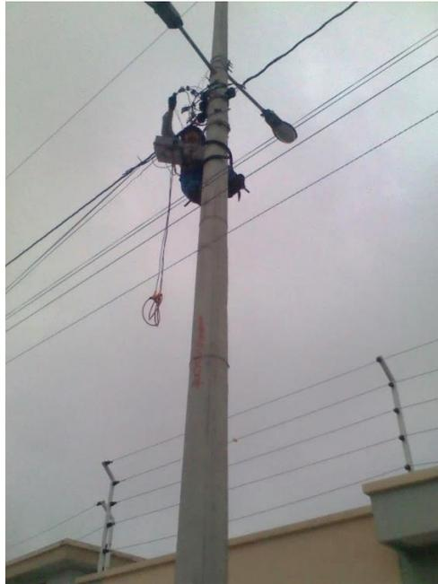
Figura 36. Conexión del analizador Fluke 1744 Quality Logger
