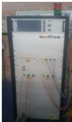
Figura 13. Equipo de ensayo en cortocircuito.
