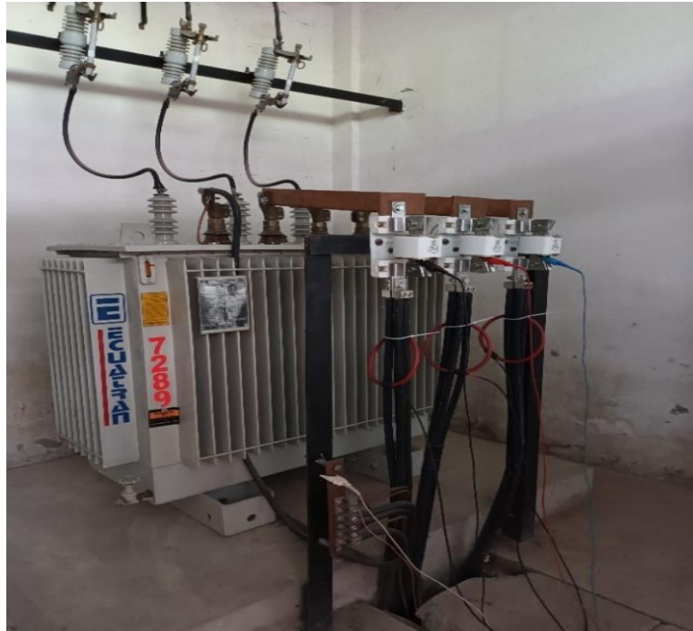
Figura 26 Instalación de registrador en la estación de bombeo Quillán 1.
