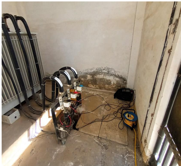
Figura 27 Instalación de registrador en la estación de bombeo Quillán 2.
