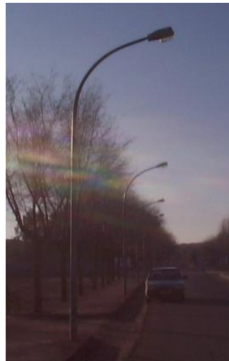
FIGURA 1.54 ALUMBRADO VIAL CON ARBOLADO
