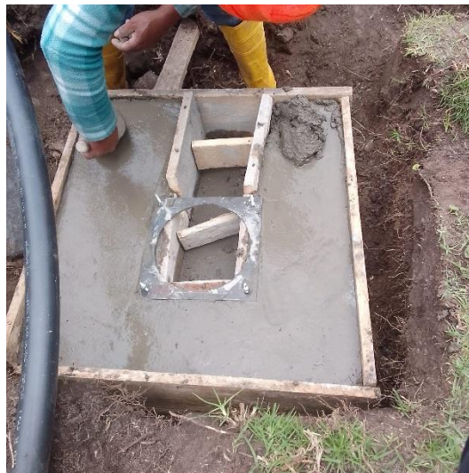
Figura 23. Construcción de la base de la CM.
