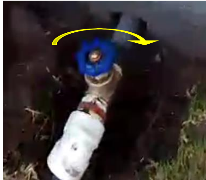
Figura 9. Cierre de la válvula girando en sentido horario.
