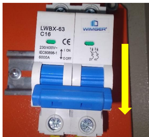
Figura 8. Desactivación del interruptor termomagnético.
