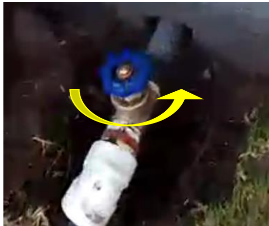
Figura 3. Apertura de la válvula girando en sentido antihorario.
