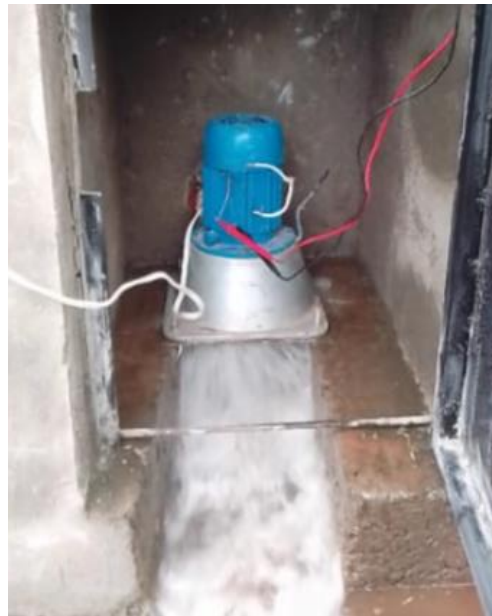
Figura 34. Funcionamiento de la Microhidráulica en vacío.
