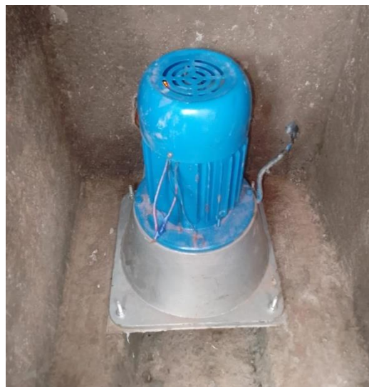
Figura 26. Montaje de la Microhidráulica.
