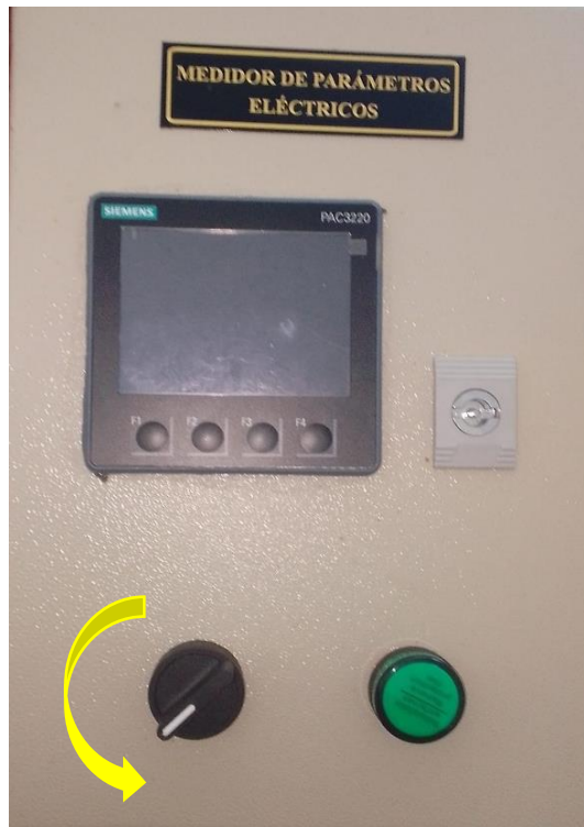
Figura 7. Desactivación del medidor.
