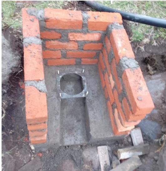
(a) Paredes de la casa de máquinas.
