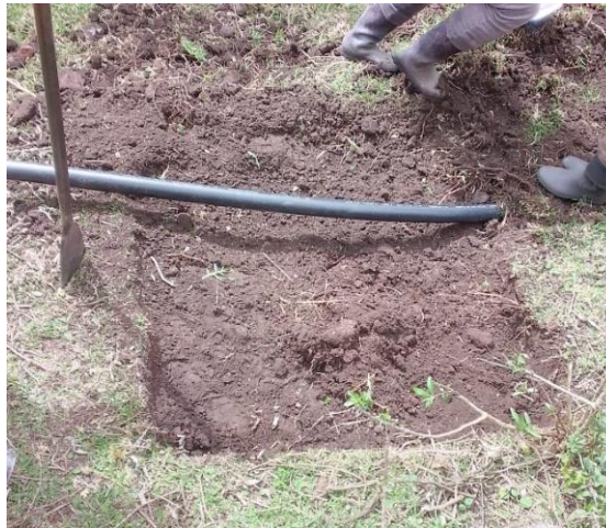
Figura 22. Preparación del suelo para la base de la casa de máquinas.
