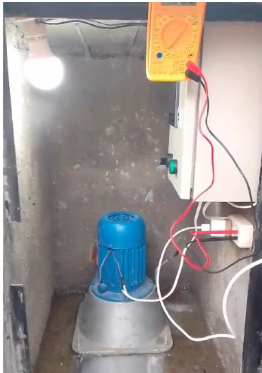
Figura 1. Pico central hidroeléctrica de 500 W.
