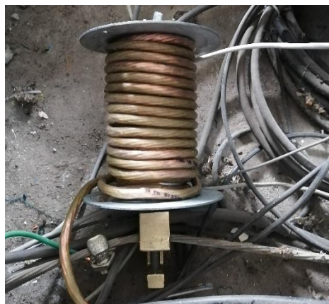
Figura 15. Puesta a tierra de la instalación.
