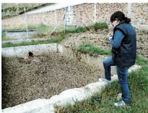
Fotografía 11 y 12. Primer tanque de sedimentación
