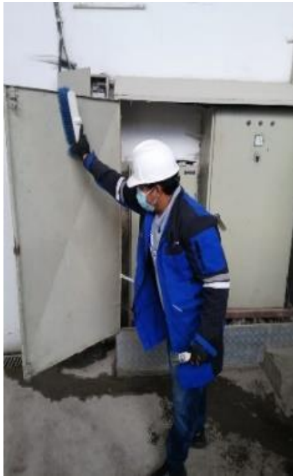
(a) Limpieza del tablero eléctrico.
