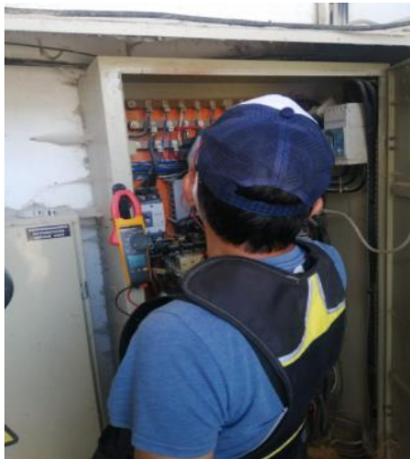
Instalación del analizador de redes y registro de medidas de intensidades
