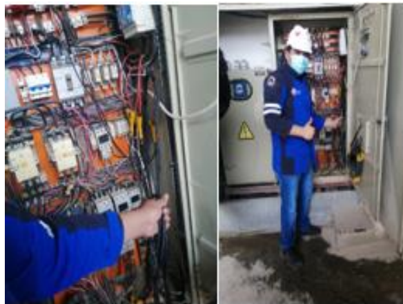
Figura 4.17 Conexión en configuración en estrella tablero principal.
