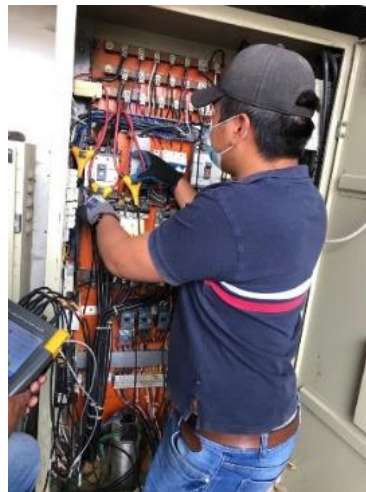
Figura 4.19 Conexión en delta motor de 50hp molino.
