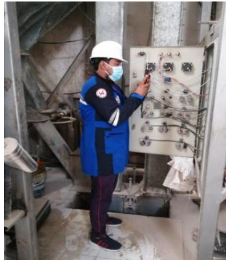
Instalación del analizador de redes y registro de medidas de intensidades
