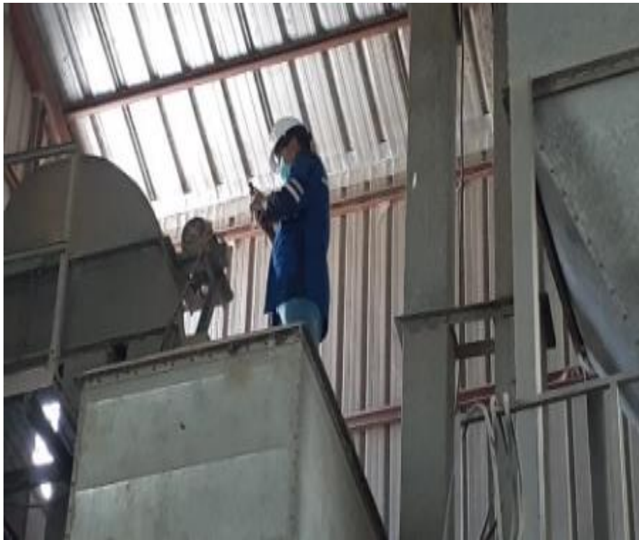
Figura 4.37 Toma de imagen termográfica a motores eléctricos.
