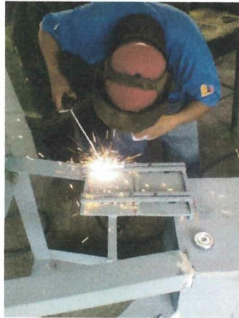
FIGURA 3.14. SOLDADURA ENTRE LA BASE DEL MOTOR Y LA BASE DEL MOLINO.
