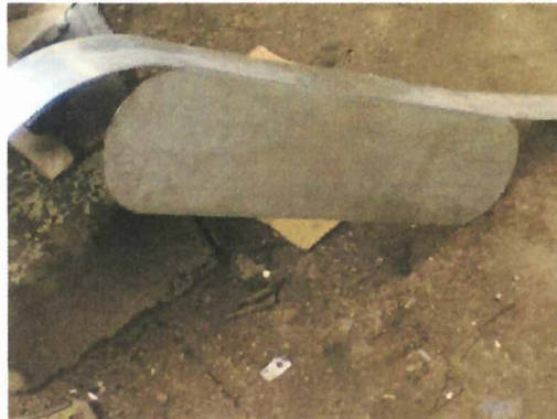
FIGURA 3.10. ESTRUCTURA DOBLADA Y BAROLADA PREVIA A LA SOLDADURA.
