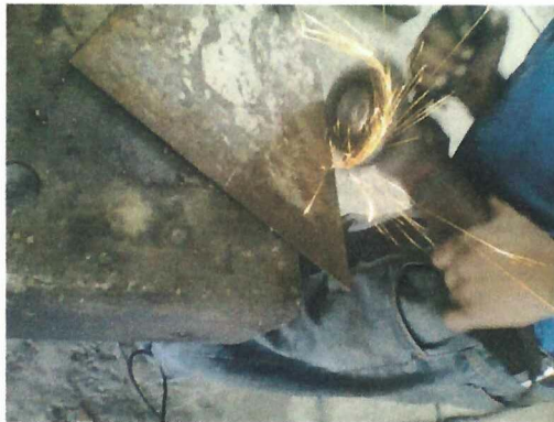
FIGURA 3.9. DECAPADO DE FILOS PREVIOS A SOLDADURA.
