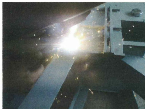
FIGURA 3.11. SOLDADURA ENTRE BASE DEL MOLINO Y CÁMARA DE TRITURACIÓN.
