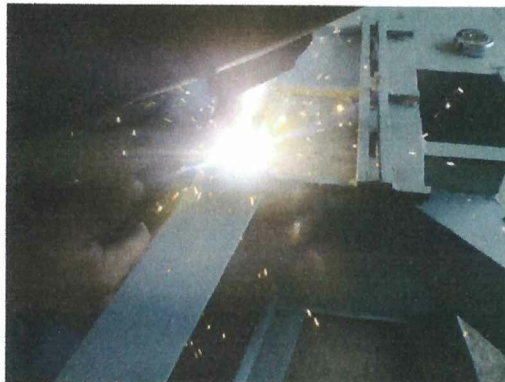
FIGURA 3.6. SOLDADURA ENTRE BASE DEL MOLINO Y CÁMARA DE TRITURACIÓN.
