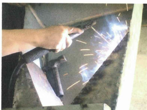
FIGURA 3.13. SOLDADURA ENTRE TOLVA Y TAPA SUPERIOR DE LA CÁMARA DE TRITURACIÓN.
