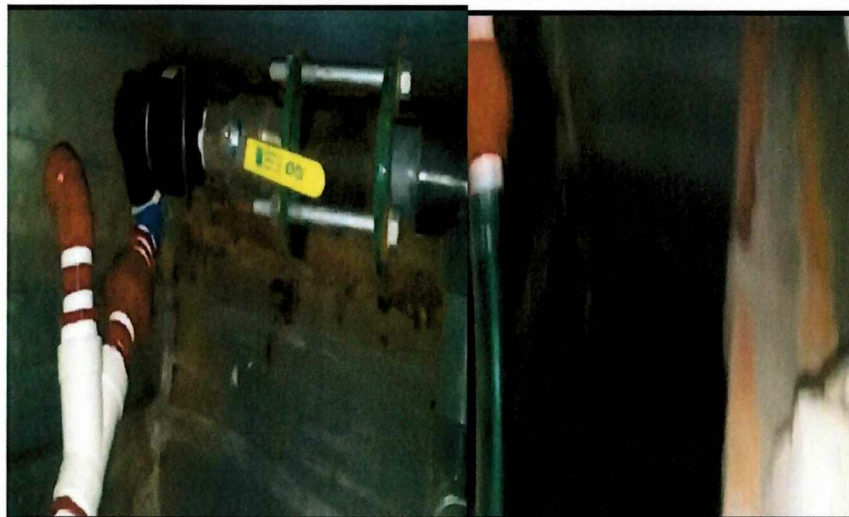
FIGURA 3.2 CULMINACIÓN DE LA TUBERÍA PRINCIPAL Y MANGUERA DE EVACUACIÓN
