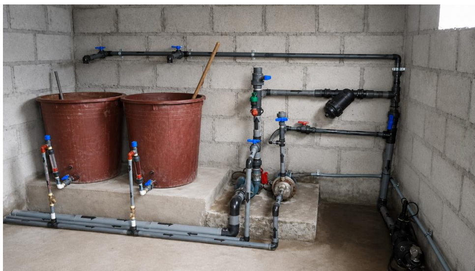
Figura 9. Vista general del sistema automatizado de inyección para fertirrigación implementado.
