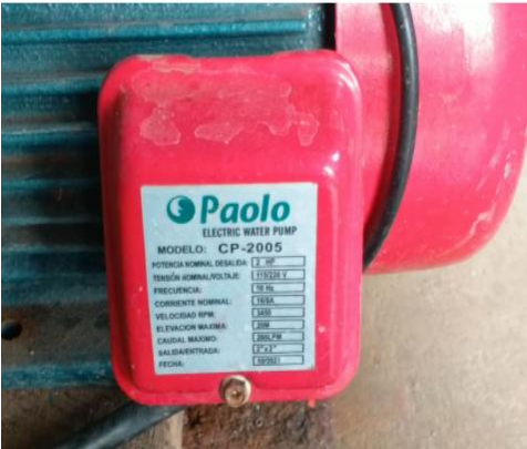
Figura 27. Placa bomba Principal
