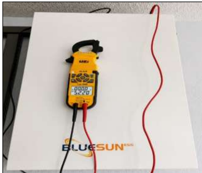
Figura. 53 Nivel de voltaje desde la batería hacia el inversor.
