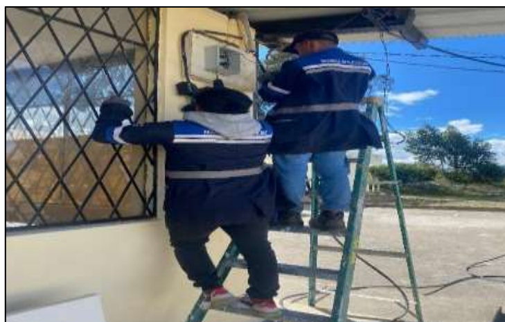
Figura. 28 Instalación de la caja de distribución.
