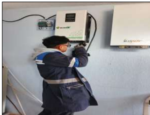
Figura. 36 Instalación del inversor en el área designada.
