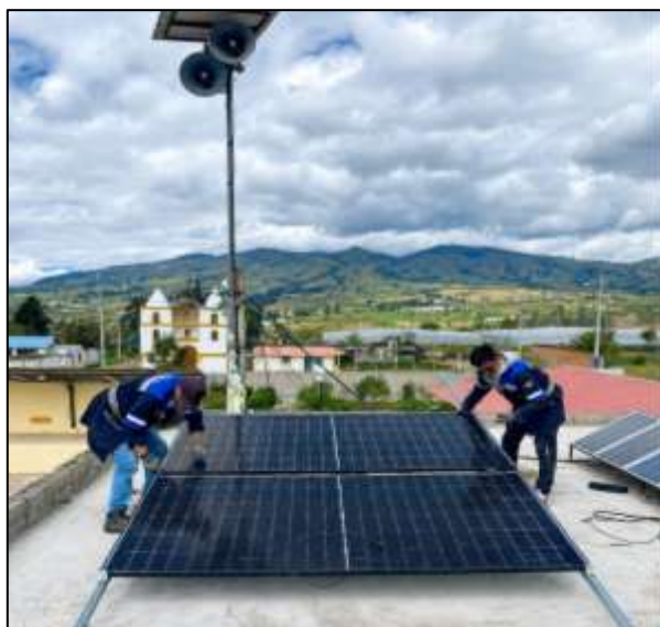
Figura. 32 Montaje de paneles solares en herrajes de aluminio.
