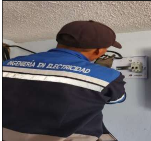
Figura. 35 Instalación de la caja de protección DC e AC.
