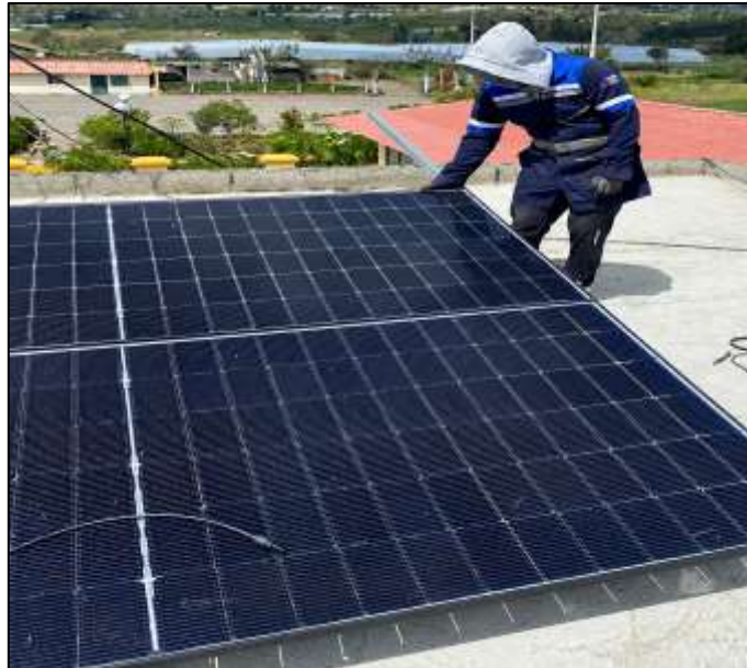
Figura. 33 Revisión e ajuste de los paneles solares.
