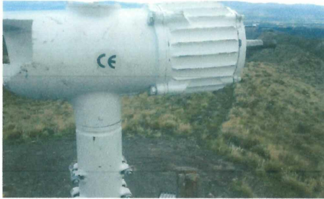
FIGURA 39. MOTAJE DEL AEROGENERADOR.
