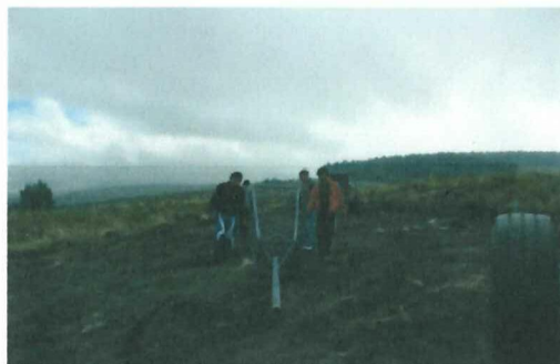
FIGURA 35. VISTA DE LA TORRE AL MOMENTO DE SU INSTALACIÓN.
