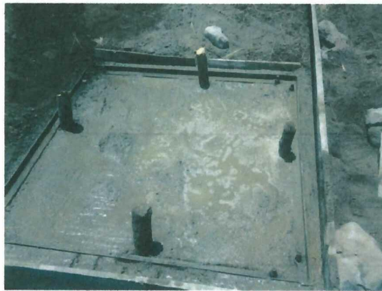
FIGURA 32. BASE DE LA TORRE TERMINADA.
