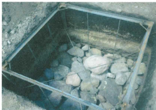
FIGURA 31. CIMENTACIÓN Y BASE DE LA TORRE AUTO SOPORTABLE.
