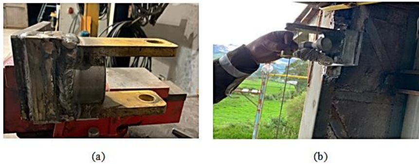
Figura 4. 16. Soldadura e instalación de base del cable de acero.
