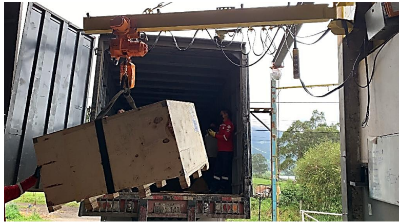
Figura 5. 6. Pruebas de funcionamiento del brazo grúa.
