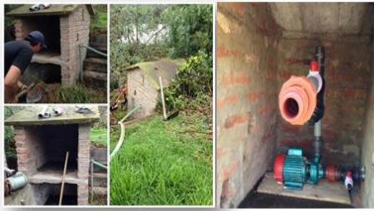
Figura 4-19: Adecuación del área para la bomba
