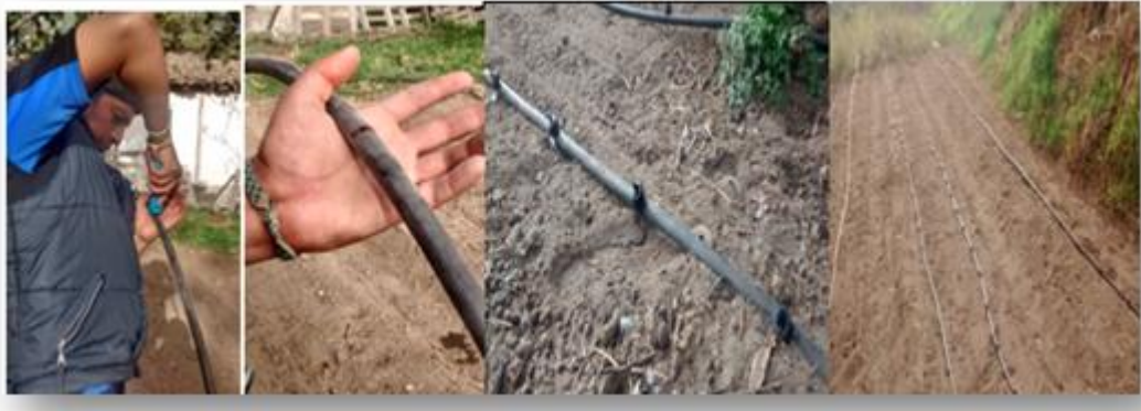
Figura 4-18: Instalando Goteo y Tubería
