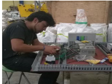
FIGURA 3. 26 Montaje de los elementos electrónicos
