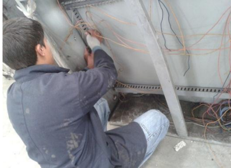
Desmontaje de la máquina
