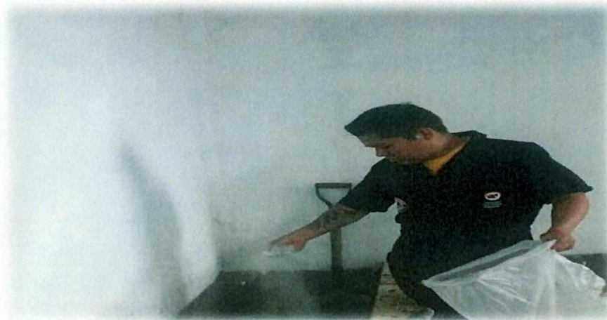
ANEXO N.20. Colocación de cal en la poza.
