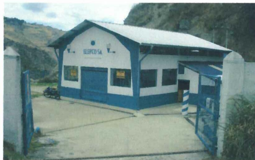
Figura 2.12 Ingreso frontal a la casa de máquinas
