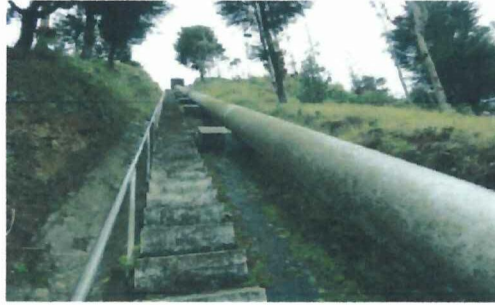
Figura 2.10 Pendiente de la tubería de presión
