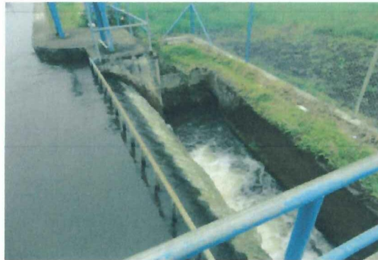
Figura 2.8 Vista del Vertedero
