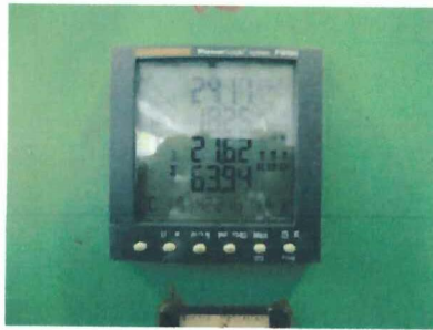
Figura 2.19 Medidor de la Energía
