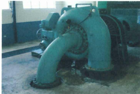
Figura 2.13 Turbina Tipo Francis
