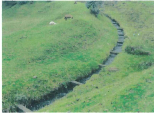
Figura 2.5 Conducción a superficie libre
