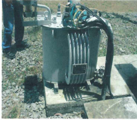
Figura 2.14 Transformador auxiliar
