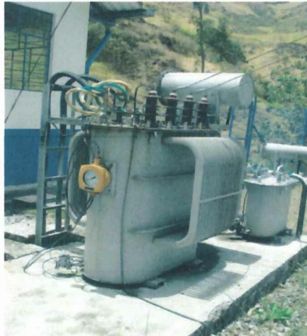
Figura 2.16 Transformador principal
