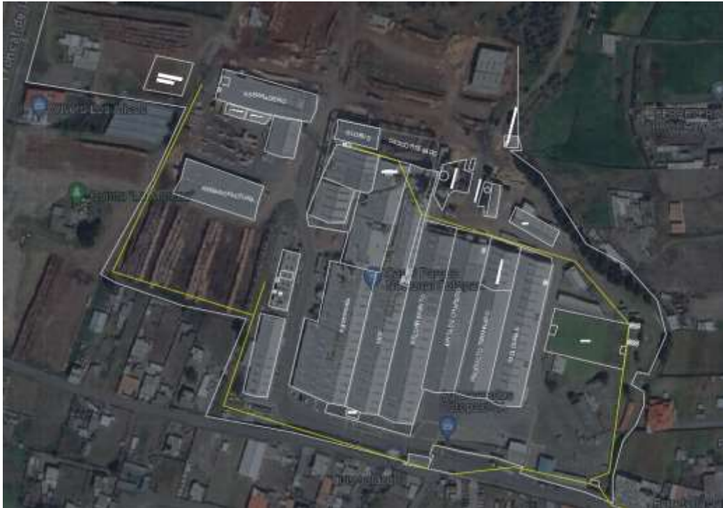
Figura 5.1. Vista general de las líneas de alimentación y áreas de producción de la empresa.
