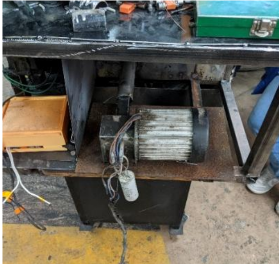
Figura 33. Colocación de nuevo motor
