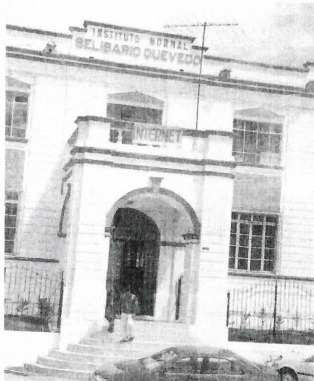
Edificio del Instituto Superior Belisario Quevedo
