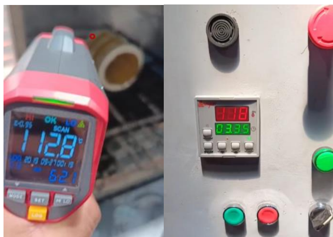
Figura. 14 Prueba de temperatura entre la masa del estator en la cámara y la temperatura censada en el tablero de control en el lapso de 30 minutos.
