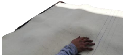
Figura. 5 Cambio de aislamiento térmico superior
