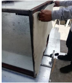
Figura. 4 Cambio aislamiento térmico lateral
