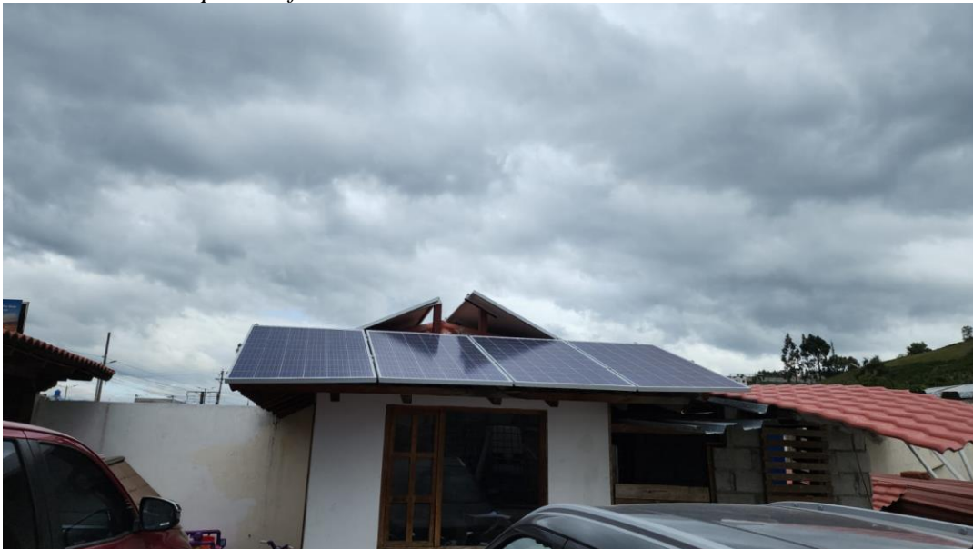
Figura 9 Colocación de los paneles fotovoltaicos
