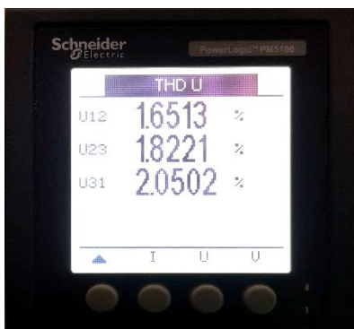
Figura 41: THD de la tensión en el analizador PM5110.
