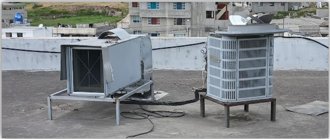
Figura 4. Sistema de Aire Acondicionado por Expansión Directa
