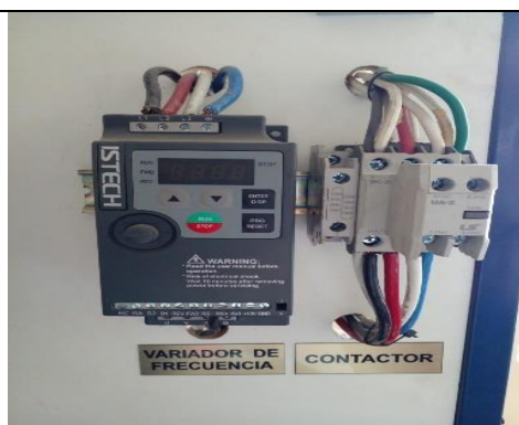
Figura 83. Enclavado del contactor
