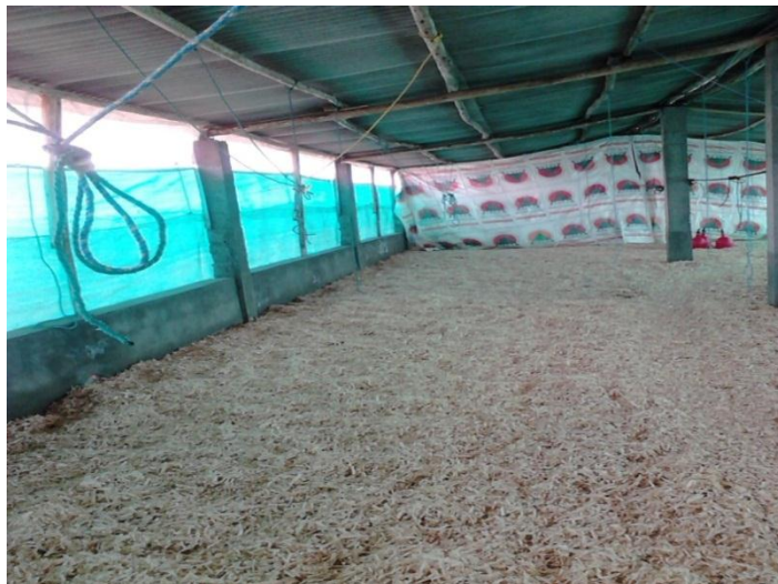
FOTOGRAFÍA 19: ÁREA DE AMPLIACIÓN DE GALPÓN
