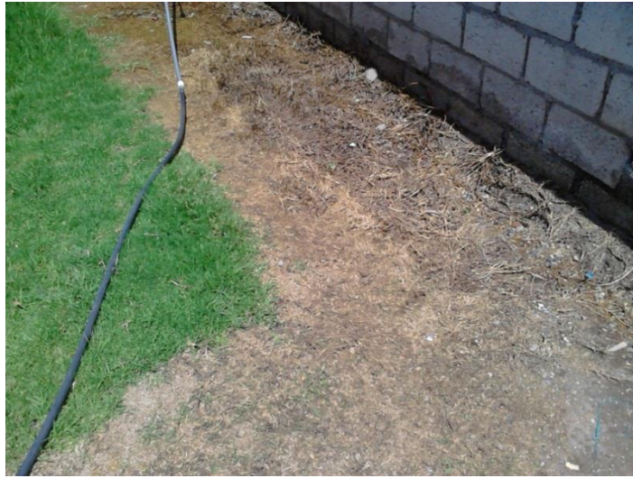
FOTOGRAFÍA 20: ÁREA EXTERIOR DE GALPÓN
