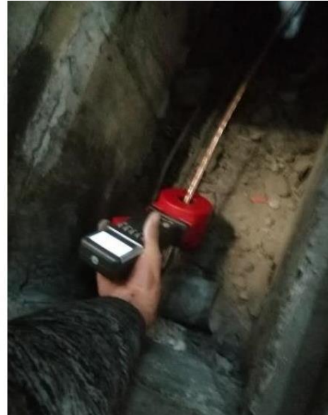
Medición de la resistencia de la malla a tierra
