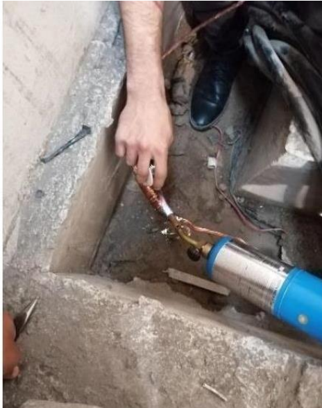
Medición de la resistencia de la malla a tierra
