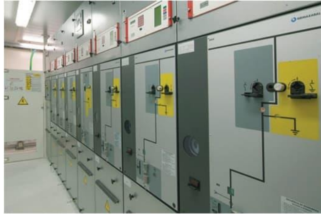
Figura 4.2. Celdas modulares
