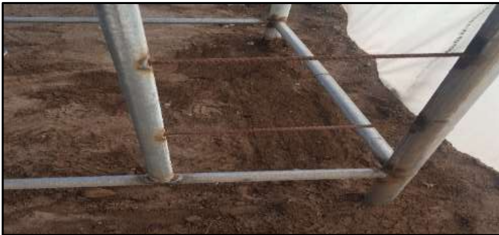
Figura II.1. Montaje de la base del tanque de abastecimiento de agua.
