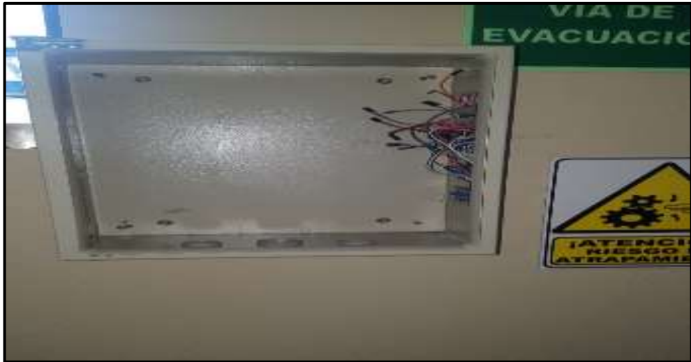
Figura V.3. Montaje del tablero en el campus Salache.
