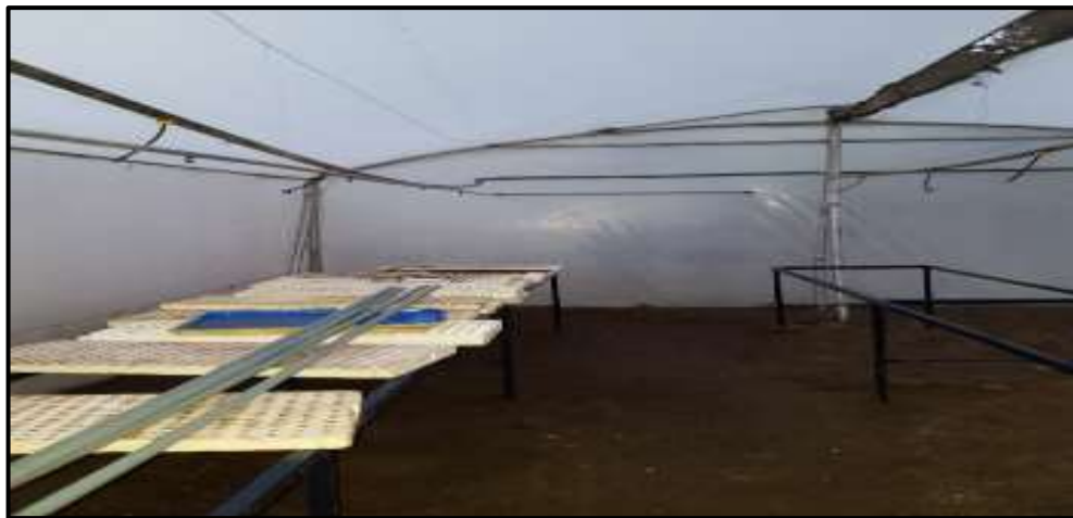
Figura VI.2. Instalación de la tubería interna del invernadero.
