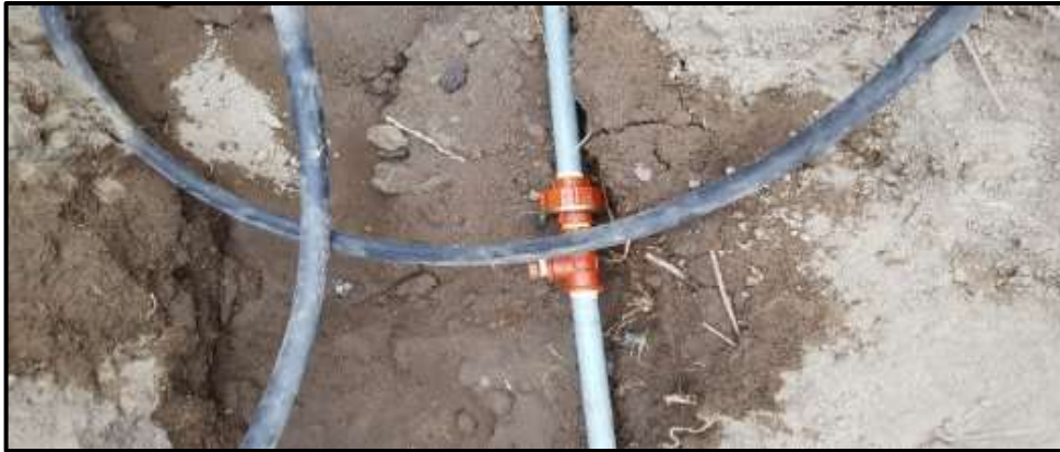
Figura III.1. Instalación de la tubería para el tanque de abastecimiento de agua.
