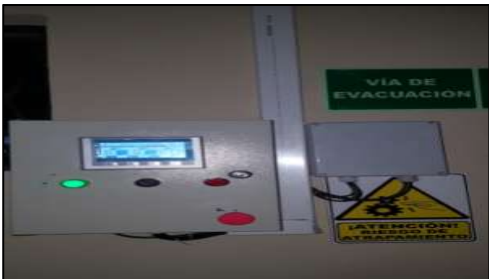
Figura V.5. Pruebas manuales del tablero de control.
