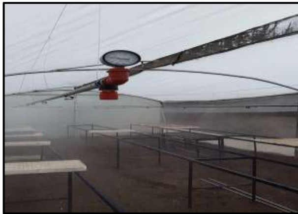
Figura 5.12. Instalación interna de la tubería.
