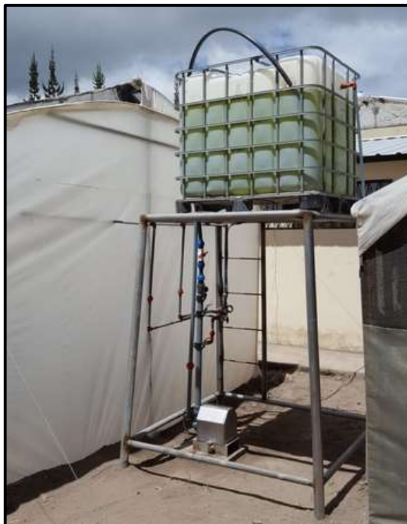
Figura 5.5. Tanque de abastecimiento de agua del invernadero.
