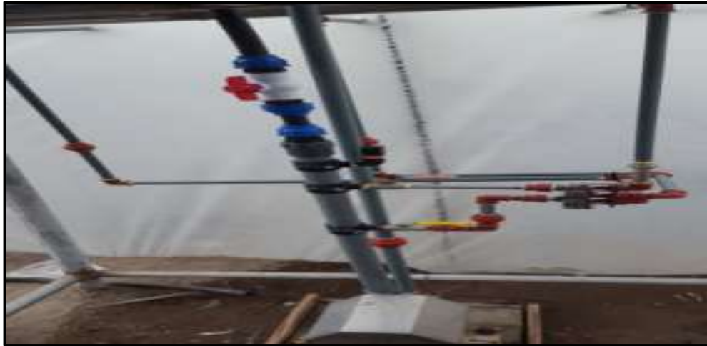
Figura VI.1. Instalación de la tubería de salida de la bomba 1Hp.
