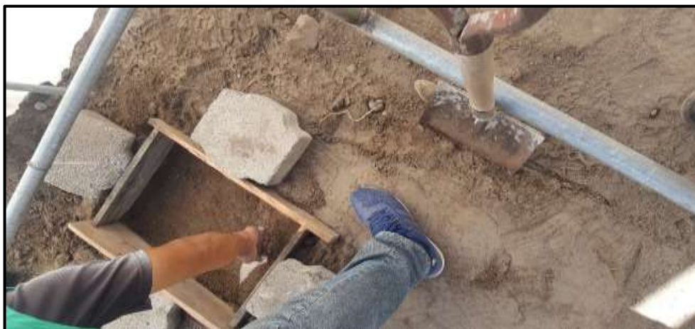
Figura II.2. Base cimentada para la bomba de 1 Hp.
