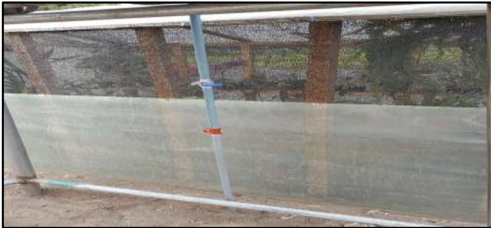
Figura III.2. Instalación de una válvula manual para el tanque de abastecimiento
