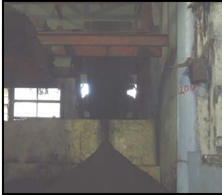
Figura 2.4. Área de recepción de la mezcla de moldeo preparada.
