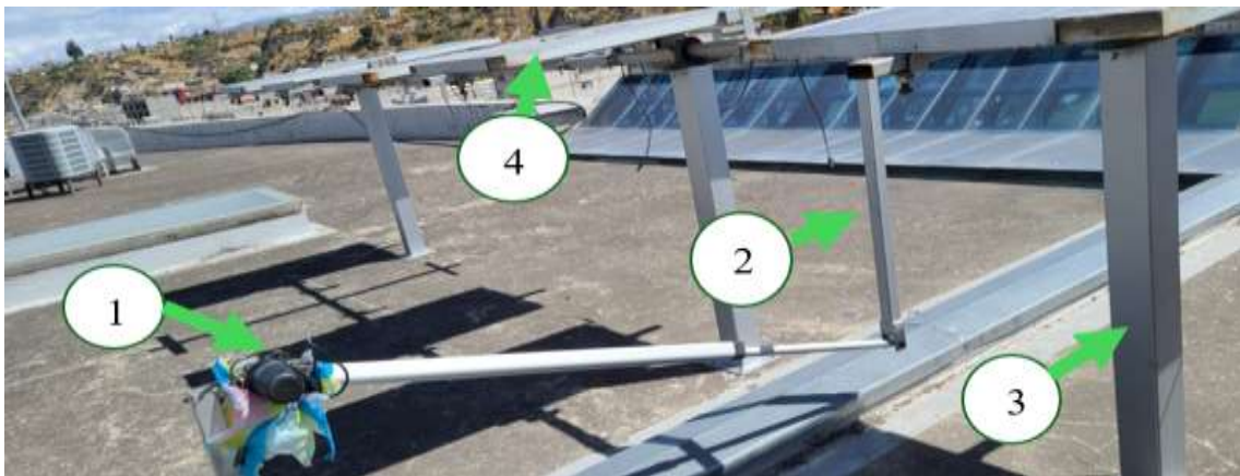
Figura 4.1. Estado inicial del seguidor solar parte A.
