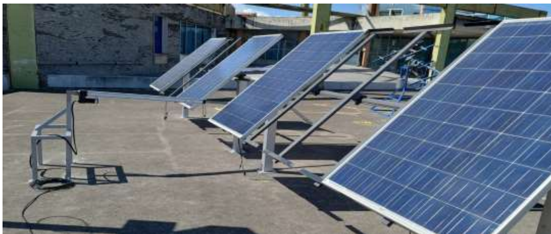
Figura 5.42. Prueba con carga.
